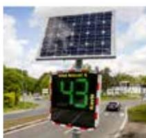
Pour la sécurité de tous les usagers, la Municipalité souhaite doter les rues de radars pédagogiques à Leds, autonomes et économiques. Leur installation ne nécessite aucune tranchée pour raccorder l'alimentation électrique.
