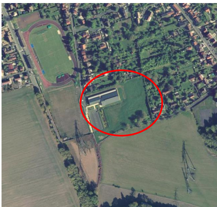
1 - Equipements sportifs au Sud-Ouest
