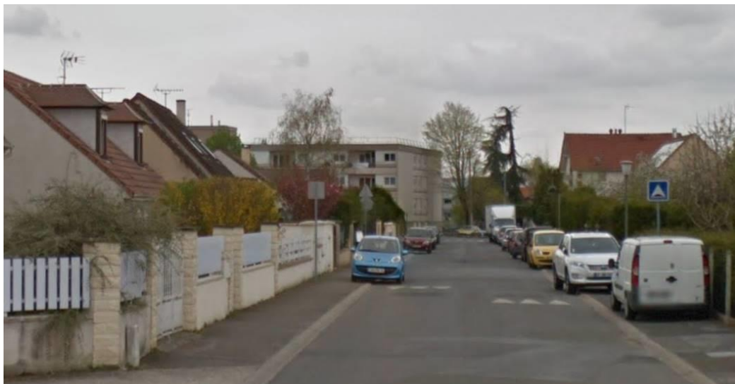
Lotissement rue de Verdun, et en arrière-plan, barre d'immeuble de la rue de Boyenal
