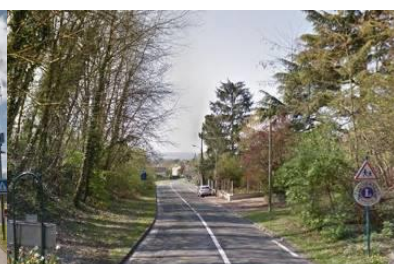
Entrée de ville depuis la RD 85 (Sud du territoire)
