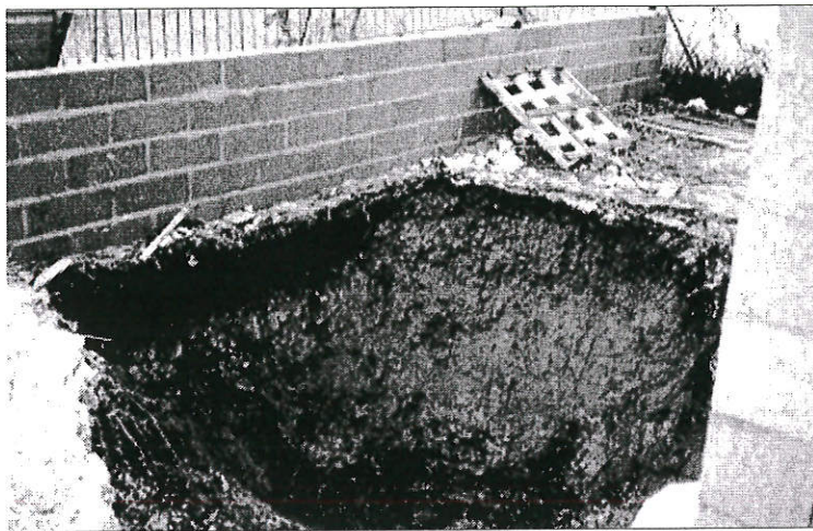
Figure n° 6. exemple d'effondrement en forme de cratère
